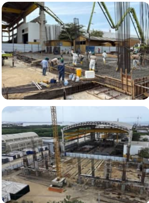
Ilustración 70 Avance en la Construcción Extensión LP2
