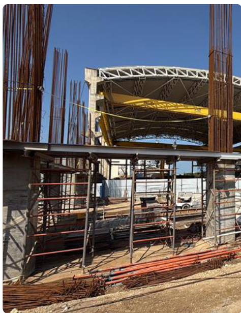
Ilustración 82 Fundición de columnas de primer nivel ejecutada. 09/feb/26
