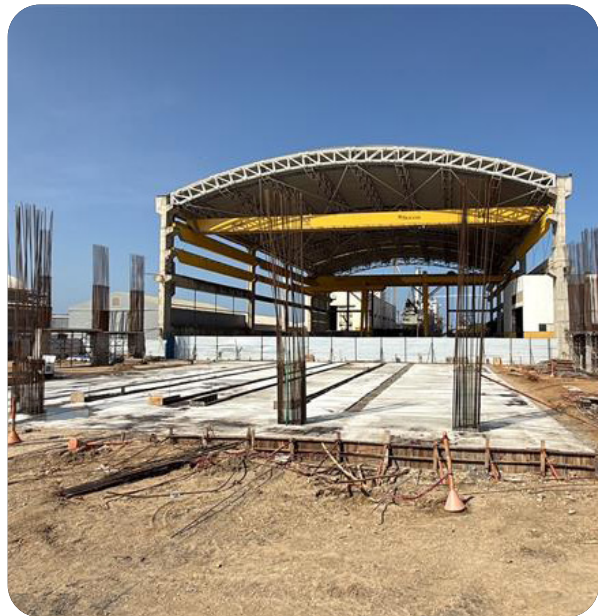
Ilustración 81 Losa estructural fundida en su totalidad 2.400 m2 - 09/feb/26.
