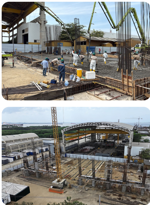
Ilustración 70 Avance en la Construcción Extensión LP2
